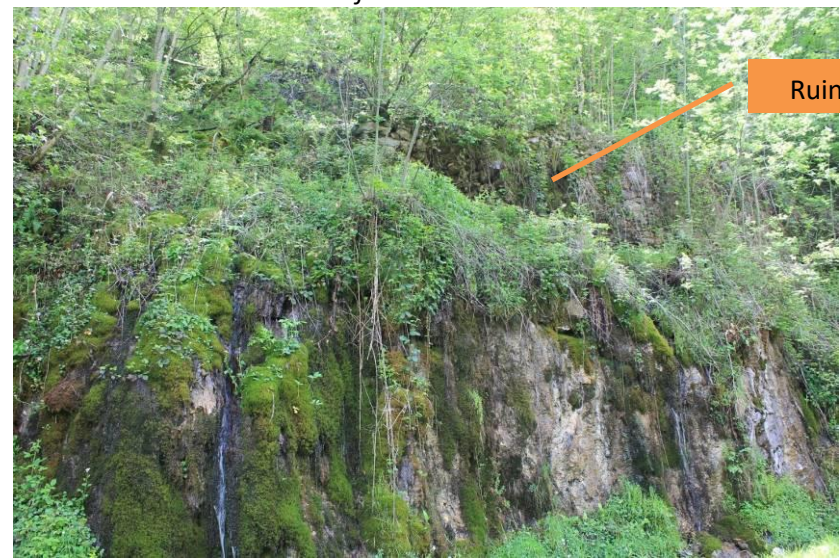
Prise de vue du 22/05/18 sur la ruine depuis la route forestière – ruine implantée à la cote ≈ 1015 m NGF
