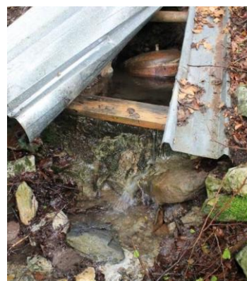
Aménagement de la retenue d'eau pour prélèvement
