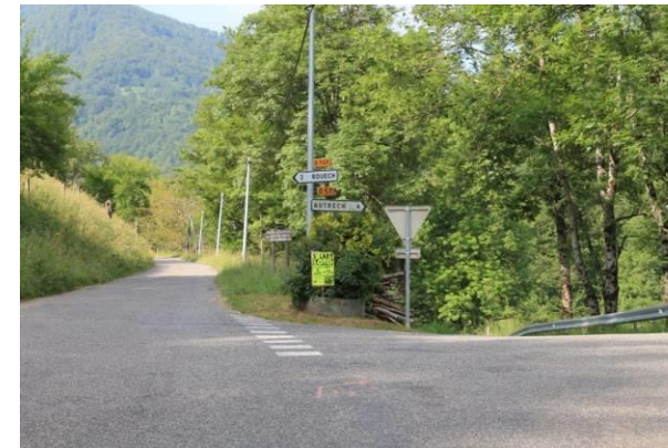
Intersection des RD 57 et RD 157 (PR 0)
