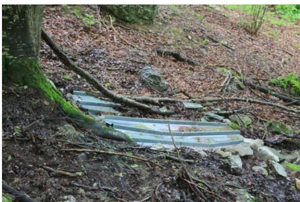
Prélèvement d'eau privé aménagé en bordure de ruissellements de pente (à hauteur des parcelles 1275 ou 1276)
