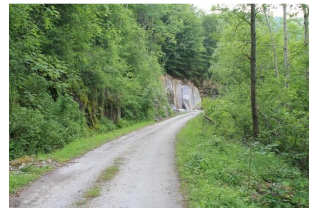
Route forestière à hauteur du site
